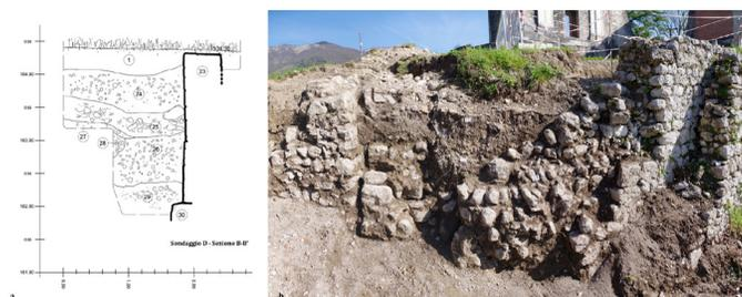
Fig. 6. Sondaggio D, ampliamento verso O - a) La sezione B-B' con la sequenza US 25, 27, 28, 26 e 29 a ridosso di USM 23. b) Visione frontale delle strutture pertinenti al Muro 6 del progetto di restauro (elaborazione grafica M. Braini, foto L. Torelli, archivio SABAP FVG).
