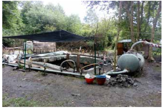
Fig. 10. Il sistema di drenaggio wellpoint impiantato attorno al Settore 3 del Palù di Livenza.
