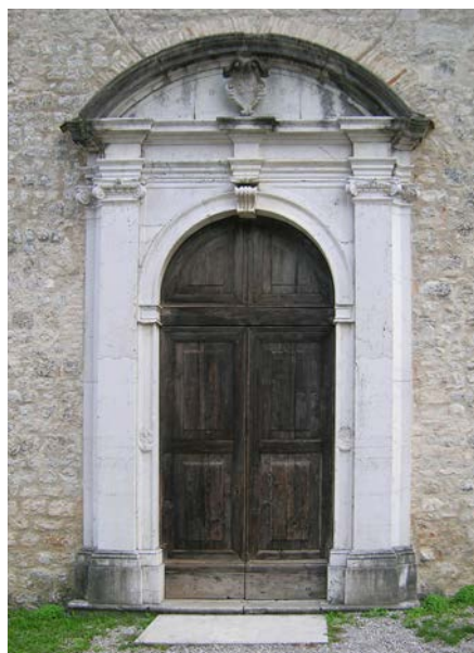
Il portone prima e dopo il restauro
