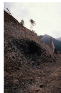
Fig. 14 (a-b-c): canale interrato in muratura; a destra: l'escavatore ha messo in luce l'ingresso di una miniera ostruito da detriti.
